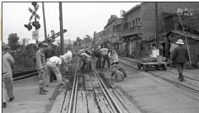
圖 4-15 萬華新店鐵路拆除情形
